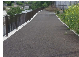
公園内通路舗装 ※イメージ
