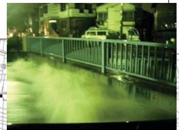
妙正寺川天神橋の様子
