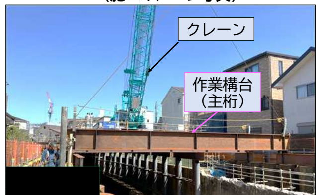
〈施工イメージ写真〉
