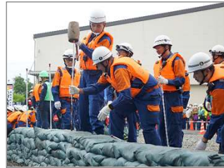
積み土嚢訓練
