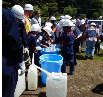
身近なレジ袋を使用した水のう作り 簡易水防工法
