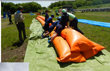
連結水のう工法 (タイガーダム)
