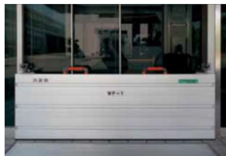
止水板 (脱着式・差し込み設置)
