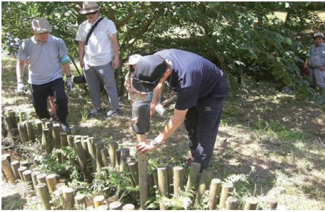
杭打ちプロ「うまい！」
