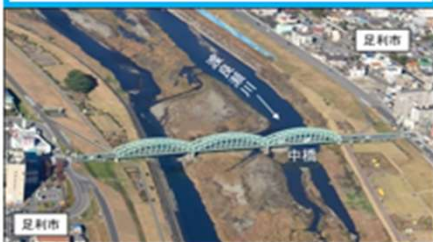
中橋橋梁架替事業
