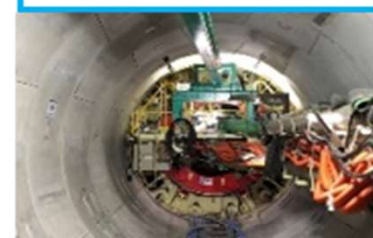
セグメント(トンネル覆工部材)組立完了時
