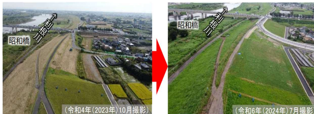
首都圏氾濫区域堤防強化対策整備状況(埼玉県羽生市)
