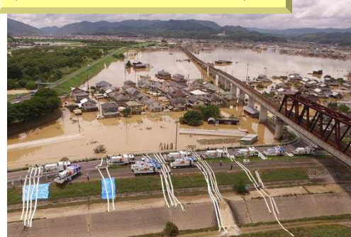
【H30.7月豪雨】 (岡山県倉敷市真備町)
