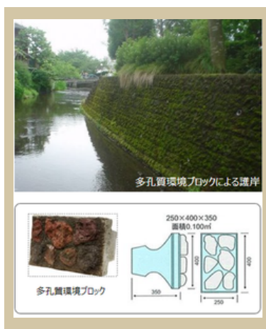
護岸には蛍の生育に配慮したブロックを使用
