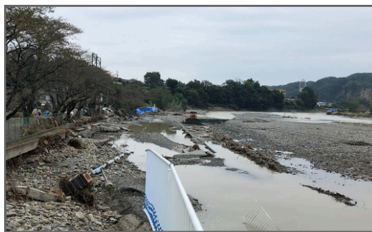
溢水して堤防が無くなった秋川の様子
