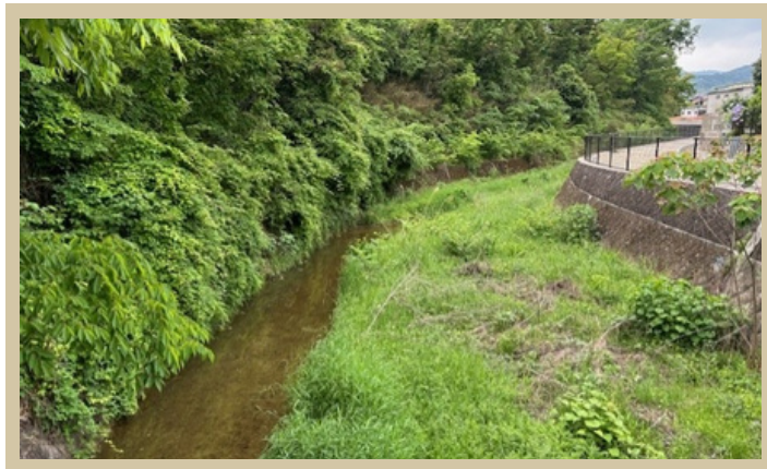
河川管理用通路を片側のみとし、河畔林や自然環境を保全
