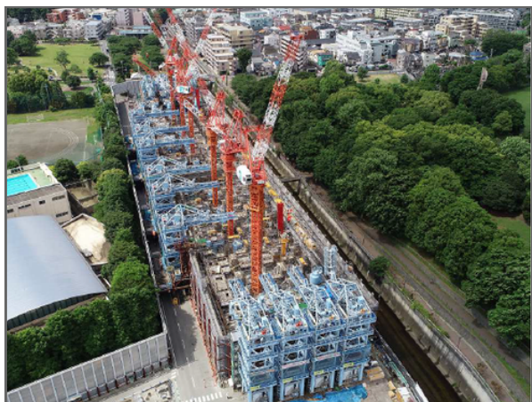
2020年ごろの整備中写真。ニューマチックケーソン工法は圧巻の景観。
