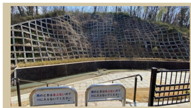
崖崩れ対策として法面整備実施後は園児のお散歩コースに ※整備後
