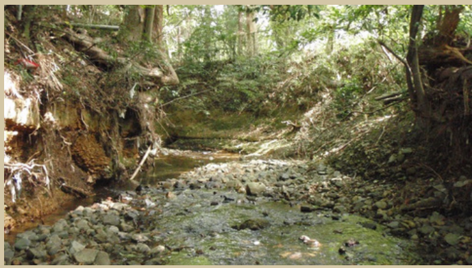
洪水による河岸侵食や河床低下が進行し、倒木の危険性も ※整備前
