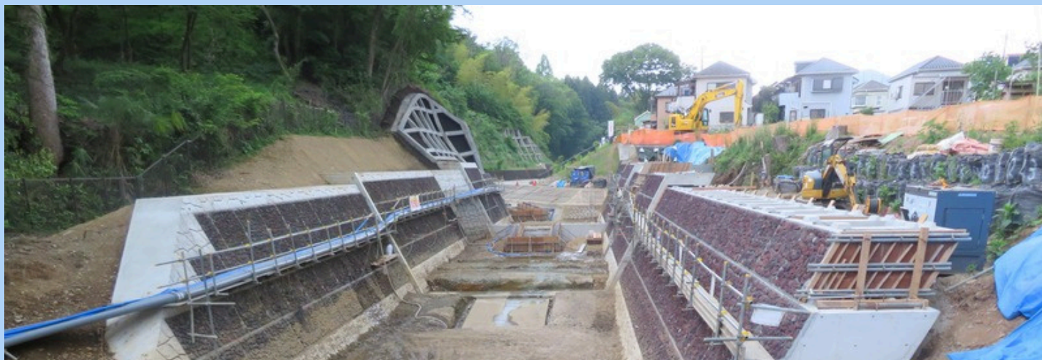
令和6年5月現在の整備現場
