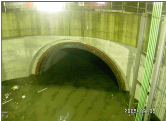
供用開始前の調節池に緊急取水
