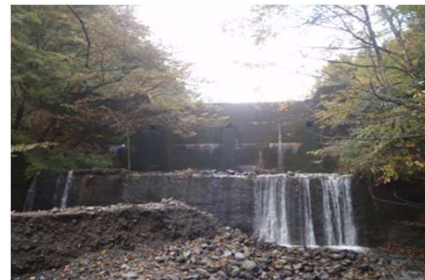
峰入川 砂防堰堤
