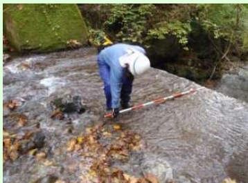
目視点検実施状況
