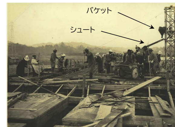
初代関戸橋コンクリート打込み状況 東京都建設局所蔵(昭和11年12月撮影)
