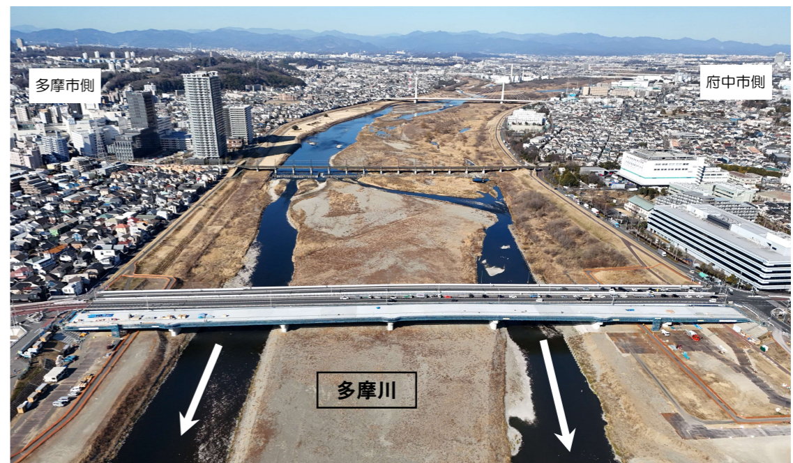
10・11年目工事状況（全景）（多摩川下流側から上流側を望む）令和8年2月撮影
