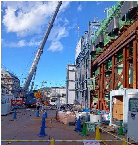
防音ハウスの組立状況
