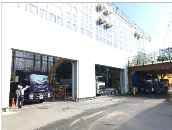
土砂搬出作業の状況事例
