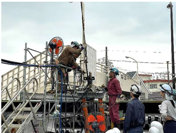
凍結管の抜去状況
