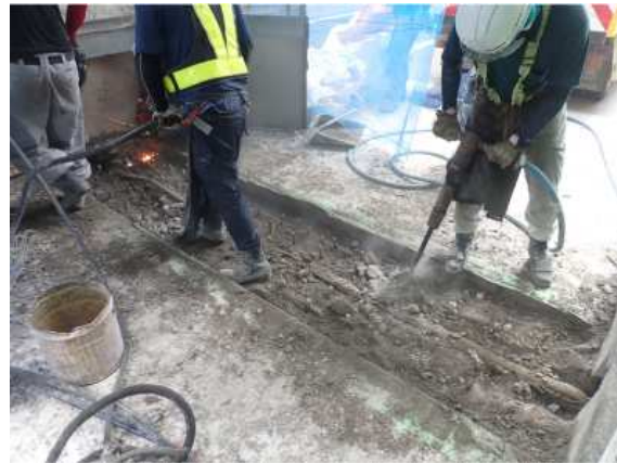
写真-④ 既設伸縮装置撤去状況
