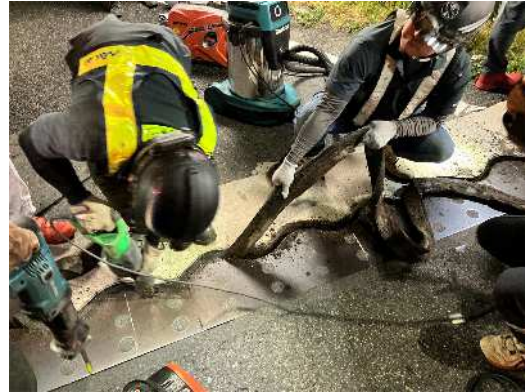
写真-② Exリライフ工法
