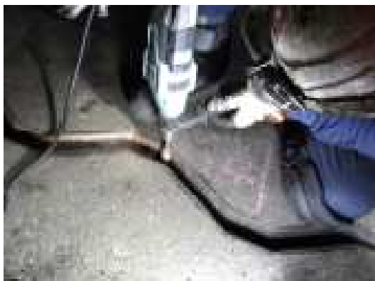
写真-⑨ Exリライフ工法(下地処理)
