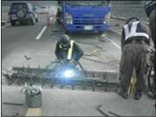
写真-① 伸縮装置取替工
