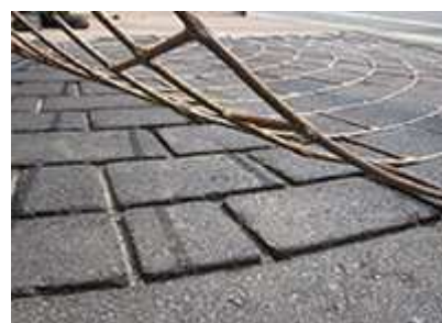
鉄網テンプレートによる模様付け
