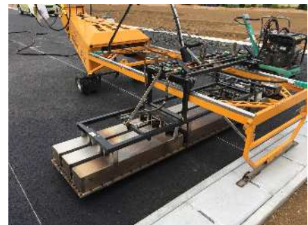
専用路面ヒーター
