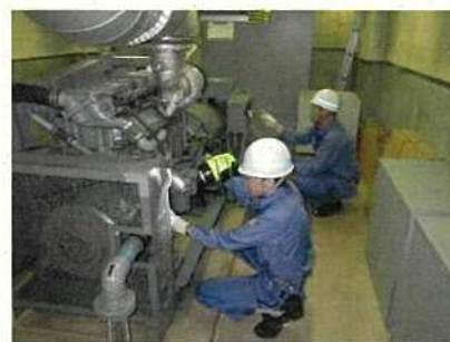
【設備点検の様子】
