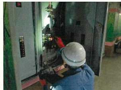
【応急的な補修の様子】
