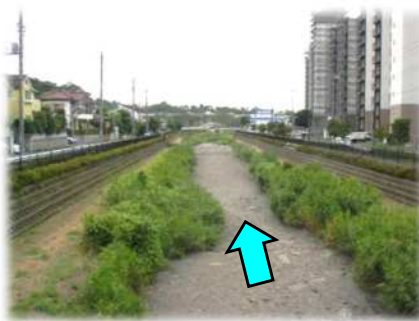
小足立橋下流
