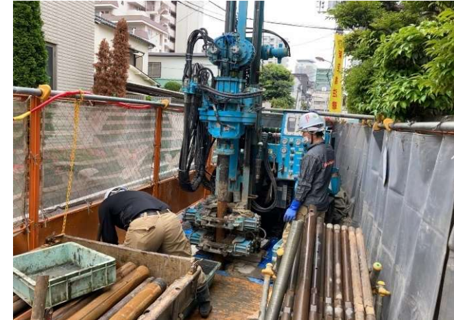
ボーリング調査状況
