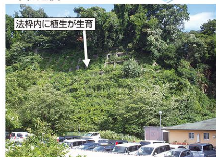
多摩市連光寺一丁目地区の法枠工
