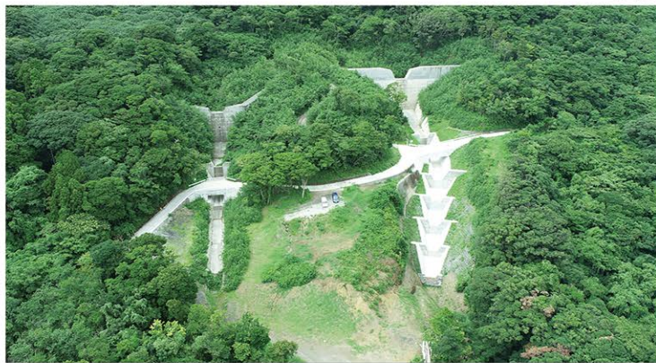
筑穴ヶ沢 2号、3号堰堤及び導流工 (三宅島)
