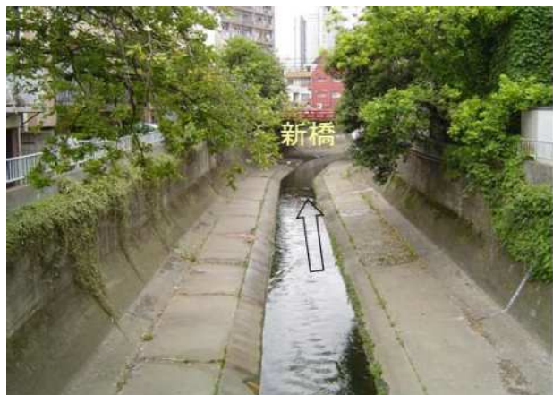
整備前(新橋上流)
