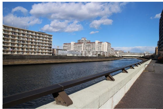
新河岸川の防潮堤・管理用通路
