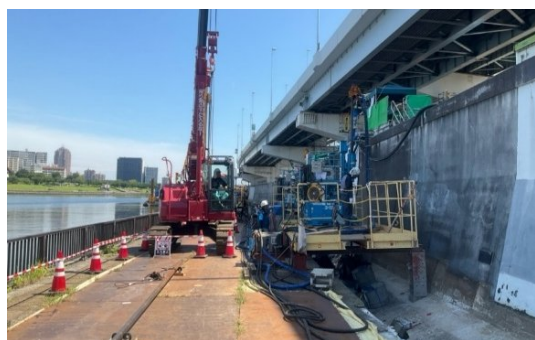
堤防の耐震対策（隅田川）
