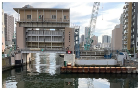
水門の耐震対策（亀島川水門）
