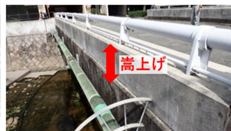
高欄部の止水対策の事例
