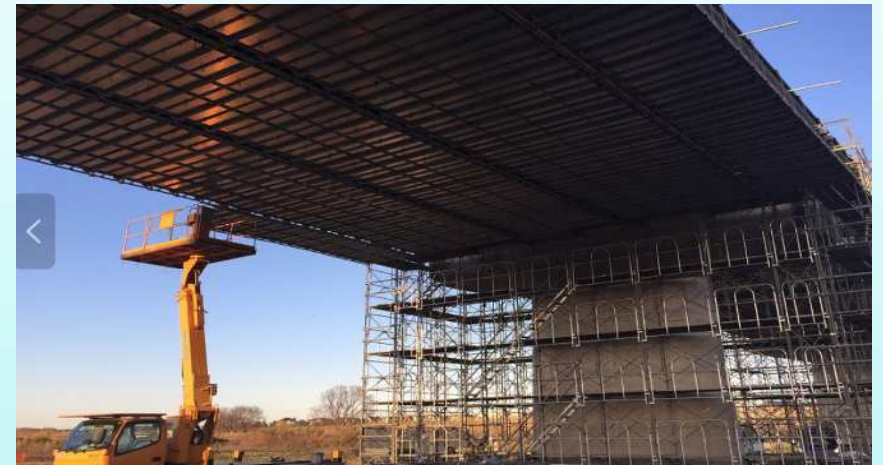
高所作業車・足場設置例
