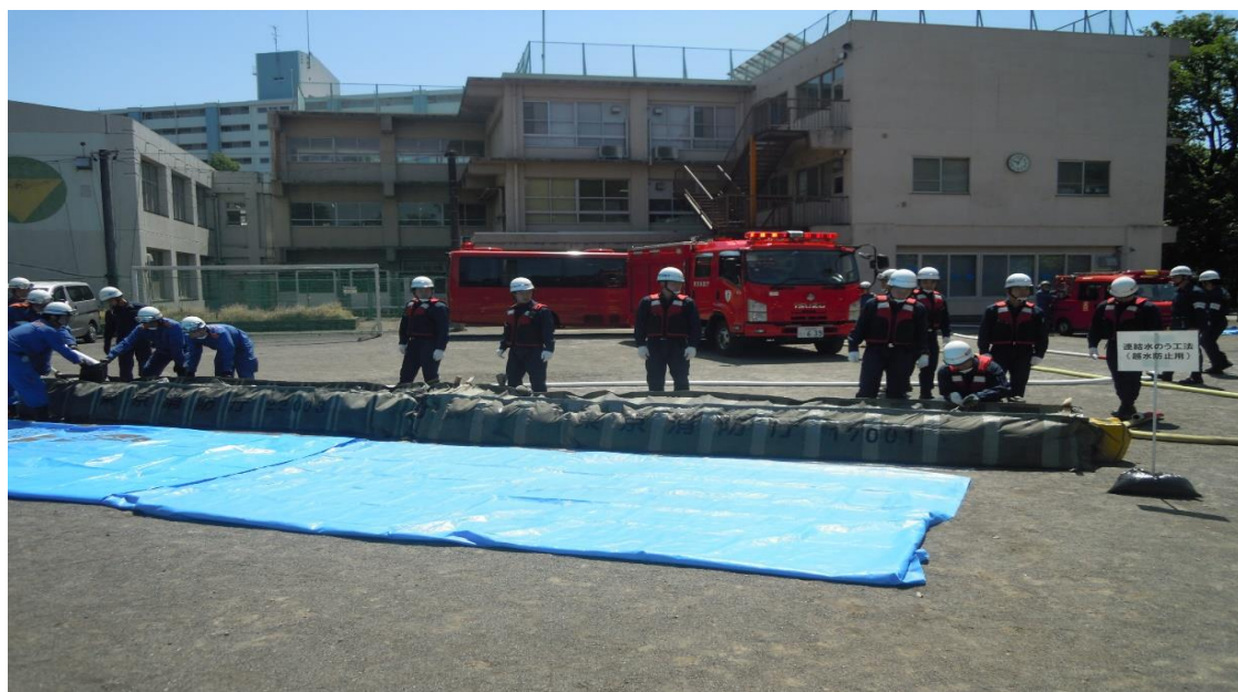
③越水防止用連結小のう工法の訓練
