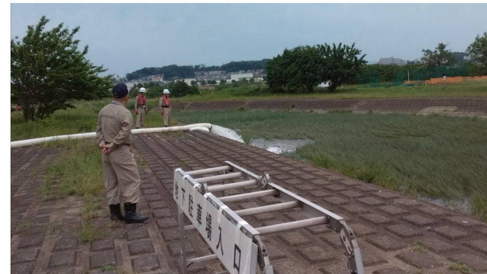
排水している様子
