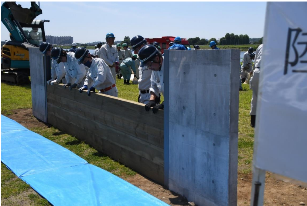
陸閘閉鎖訓練の様子
