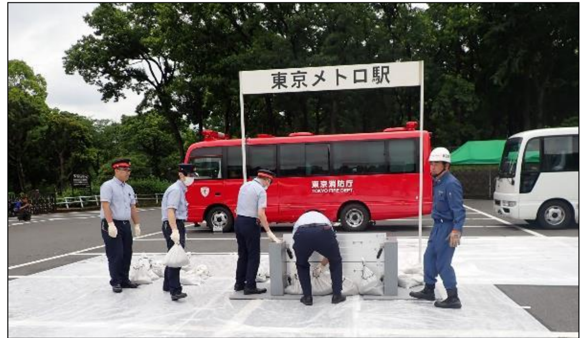
▲ 地下鉄浸水防止工法の様子
