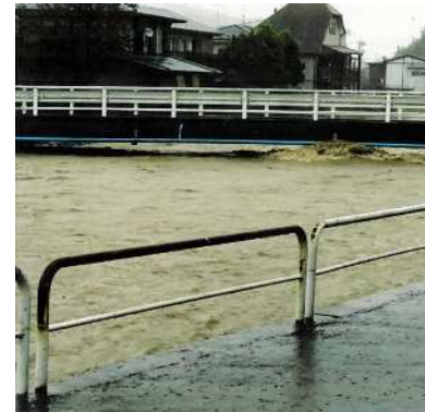
R元.10月 西田橋増水状況
