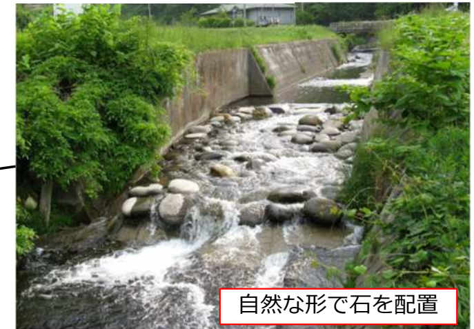
自然石落差工（施工例）
