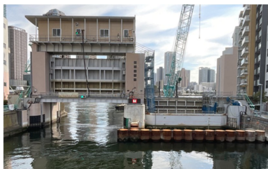
水門の耐震対策（亀島川水門）
