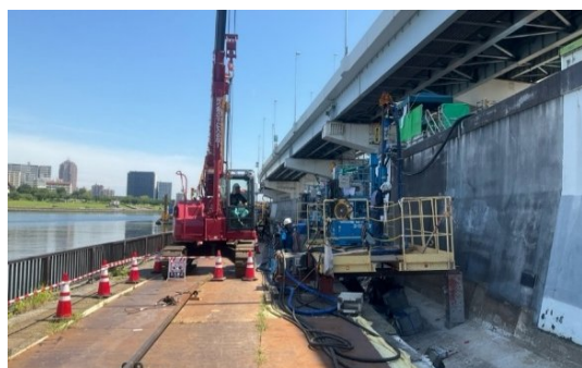
堤防の耐震対策（隅田川）
