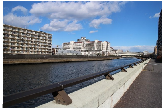
新河岸川の防潮堤・管理用通路
