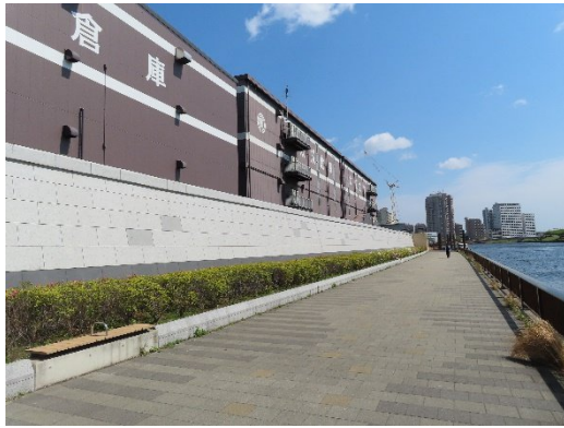
防潮堤（隅田川）
