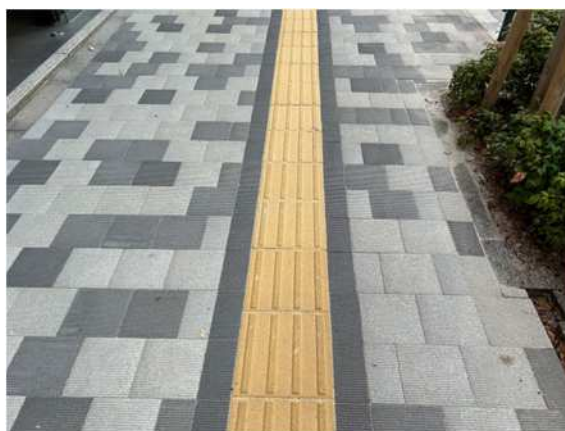
図 4-9 輝度比を考慮した視覚障害者誘導用ブロックの設置例
