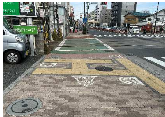
図 4-11 踏切道手前の視覚障害者誘導用ブロックの設置例
