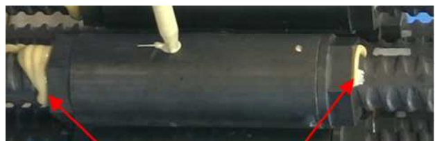
【写真-1】 グラウト充填の確認方法
