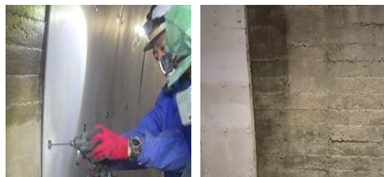
曲率が異なる箇所へ設置（下半直線 上半曲面） 型枠目違いの段差凹凸へ設置（左側設置済み）
