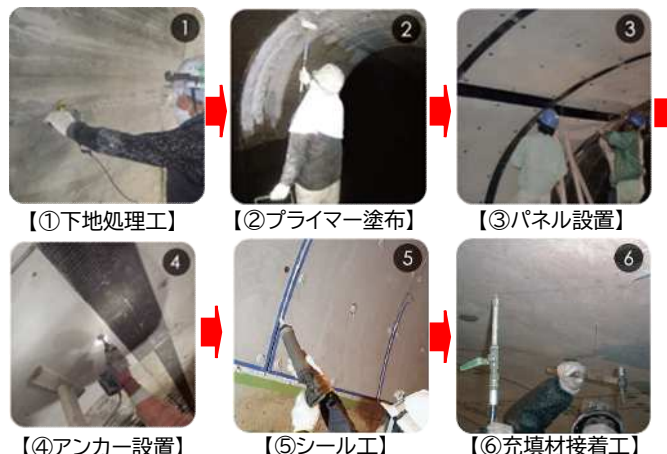
【写真-1 CFパネル工法の施工手順】
