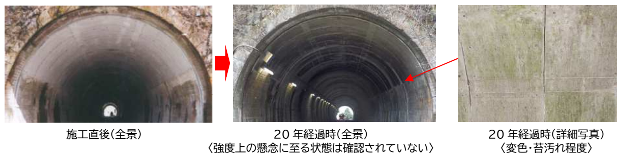
【写真-3 新技術（CFパネル工法）施工直後と施工後20年経過時の比較】
