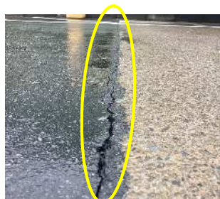
写真-2 舗装継目における適用状況(供用1年後)
