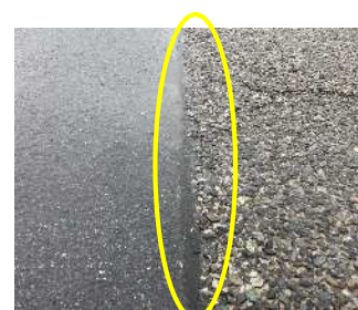
写真-2 舗装継目における適用状況(供用1年後)
