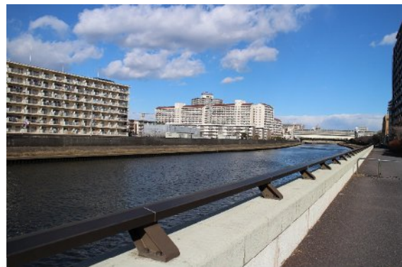
新河岸川の防潮堤・管理用通路
