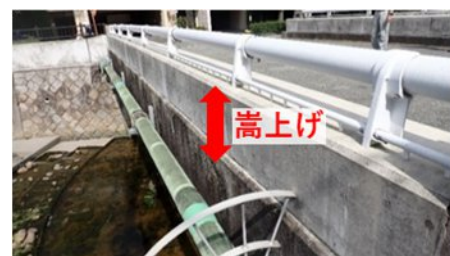
高欄部の止水対策の事例
