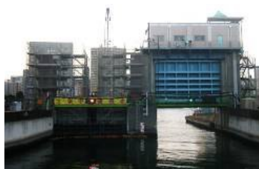
水門の耐震対策（大島川水門）
