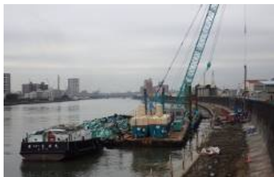
堤防の耐震対策（隅田川）
