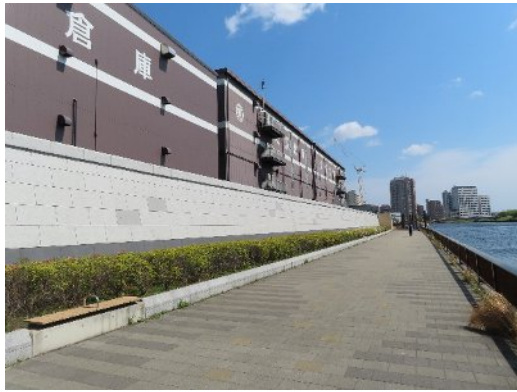
防潮堤（隅田川）
