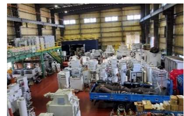
写真－１ 機材整備工場の例
