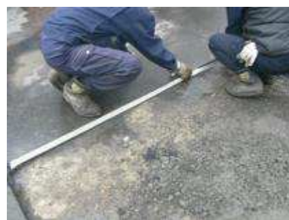
写真-3 サイドタックコート工 打ち継ぎ面へアステープドットを貼り付けているところ
