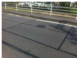
写真-4 アステープドットによるシールコート施工箇所（施工1年後、滋賀県内国道路面）
