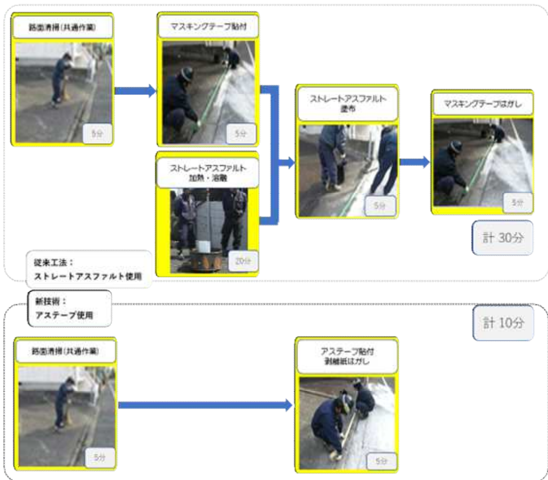
図-1 試験施工による工程比較（オーバーレイ補修工における端部接着処理50m）
