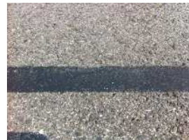
写真-4 アステープドットによるシールコート施工箇所（施工1年後、滋賀県内国道路面）
