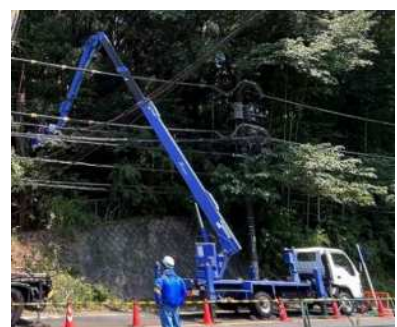
写真1 高所作業車(先端屈折型)
