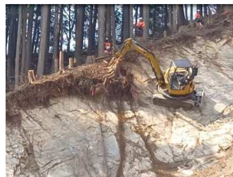
写真-4 無人化施工機械施工状況
