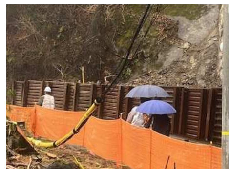
写真-3 歩行者通路の設置状況
