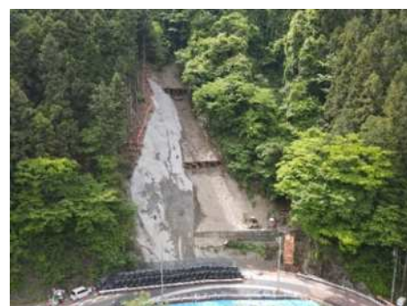
写真-5 応急対策後の斜面状況
