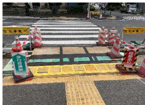
写真－１ 横断部の安全対策
