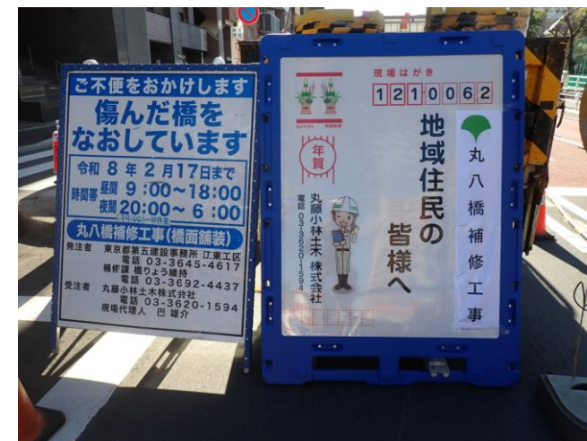
工事看板（イメージアップ）
