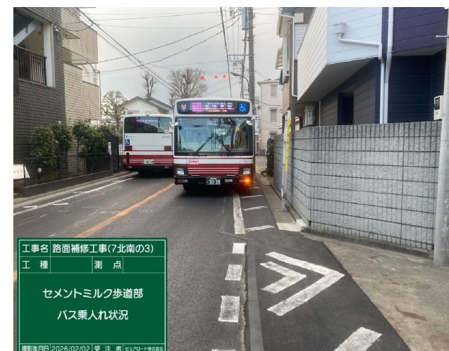
路線バス通行、住宅近接状況
