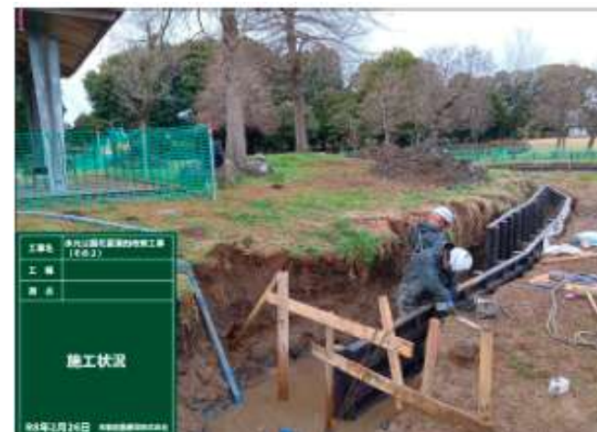
プラ擬木板柵土留の施工 1,2月の冬期に水中作業）
