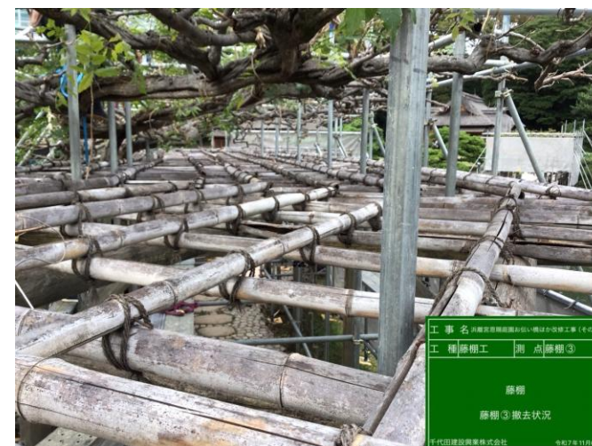
藤棚撤去前の藤の枝の吊り上げ
