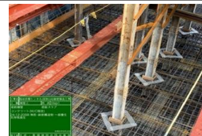
耐アルカリ性ガラス繊維ネットを設置し、ひび割れ対策を行った
