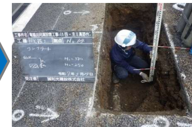
受注者による追加提案箇所の試験掘状況
