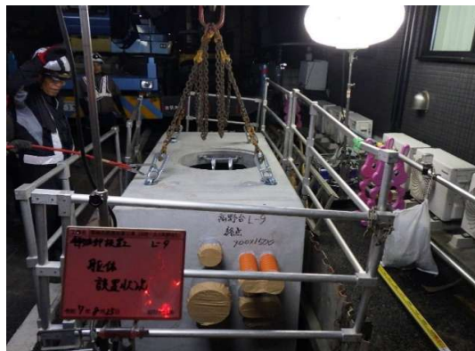
狭小な歩道における特殊部設置作業（夜間）
