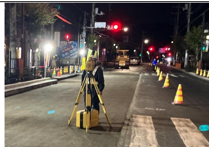
ICT（測量・建機）を活用した路盤施工状況
