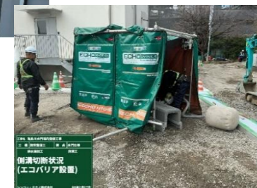
安全通路及びU字溝切断状況
