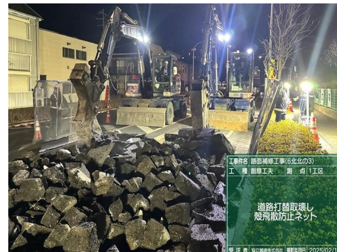
重機2台稼働及び飛散防止状況
