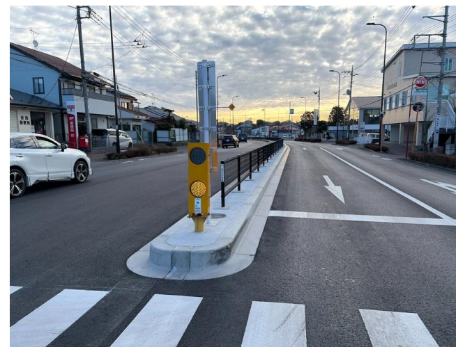
カーブかつ上流方向と下流方向の道路の高さが違ったが、綺麗な施工ができた。
