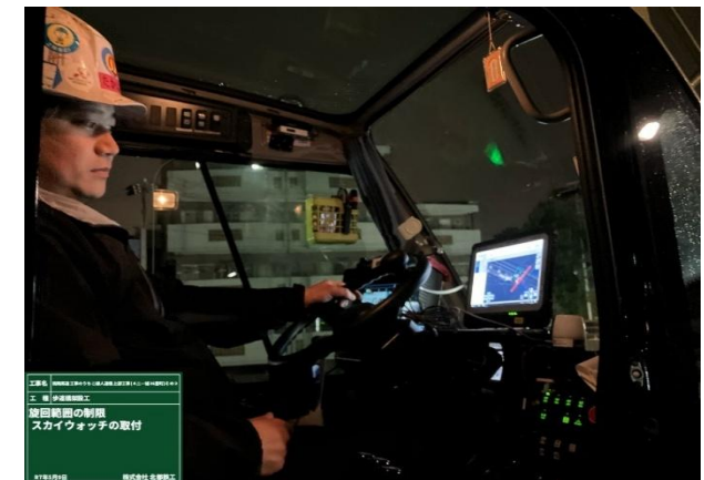
モニターによるクレーンブーム先端位置の監視状況
