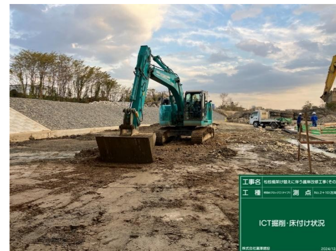
ICT建機による床付け作業
