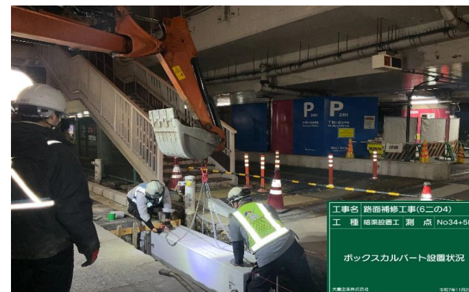
排水施設（ボックスカルバート）の設置
