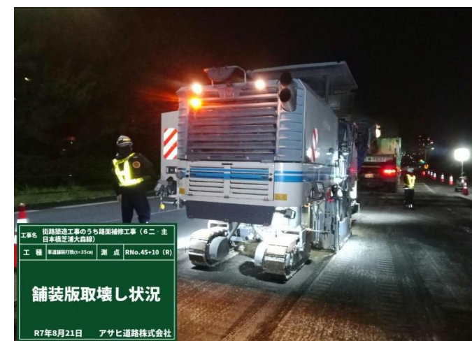
大型切削機による舗装版破碎状況
